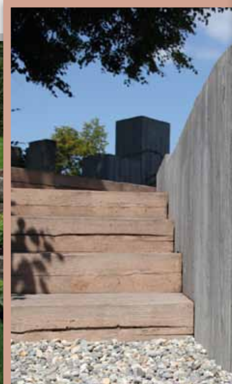
Täuschend echt: was aussieht wie Holz, ist in Wirklichkeit Beton!
